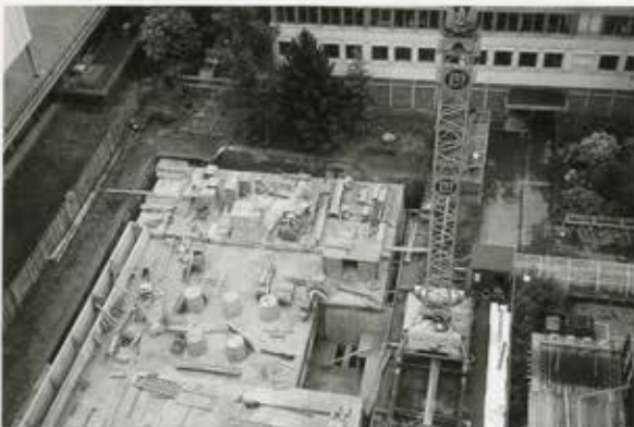
Baustelle zwischen Krankenpflegeschule und Hochhaus
