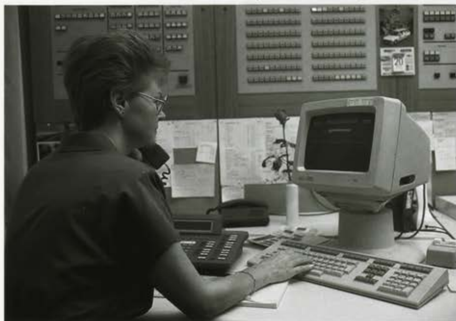
Kostenintensive Infrastruktur: Telefonvermittlung und Alarmüberwachung
